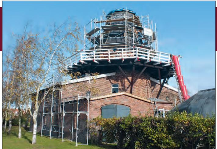
Die Galerie der Holländermühle in Neßmersiel ist bereits fertiggestellt. Im Bild wird der Achtkant verschalt.
